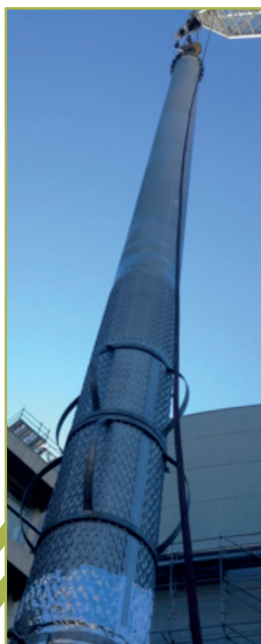
Chemisage des puits du circuit d'eau de nappe
