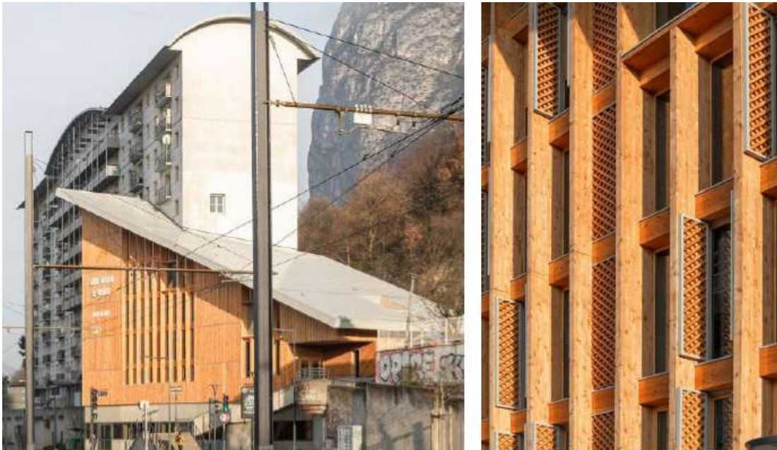
Figure 4 : Rénovation énergétique de l'Hôtel de ville de Saint-Martin-le-Vinoux– © Iris Rodet
