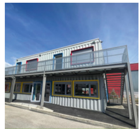
Résistants et modulables, les conteneurs peuvent être superposés, comme ici pour un usage de bureaux.
