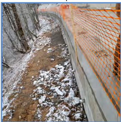
Mur de soutènement réalisé en 2021 (1ère phase)
