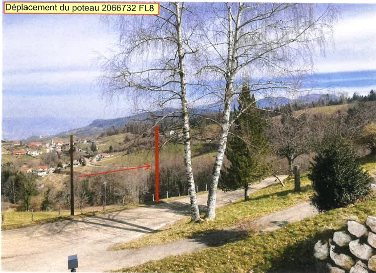
Pose nouveau poteau FL8 2081431
