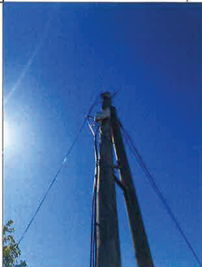
Vue tête de poteau
