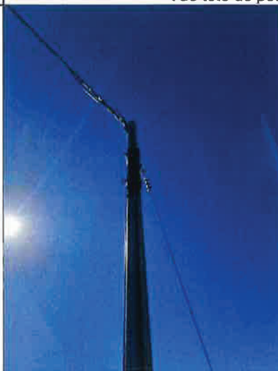
Vue tête de poteau
