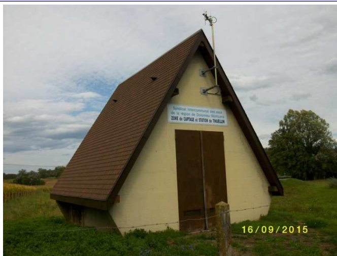
Station de surveillance des eaux souterraines – Thuellin (LDA26, 2015)
